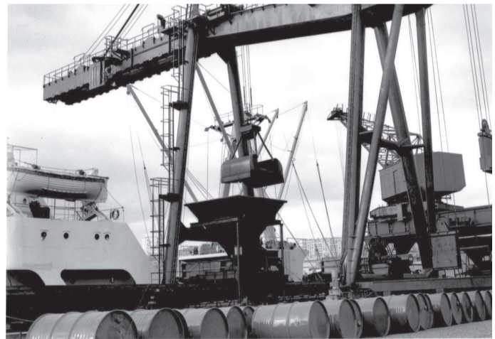
PORT DE COMMERCE DE BREST (vers 1961) - Déchargement de cargaison : vue de la grue à godet déversant du charbon dans une trémie, au premier plan des barils
