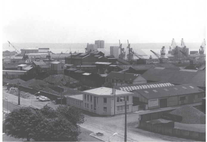
PORT DE COMMERCE DE BREST - charbon, stockage, vue d'ensemble
